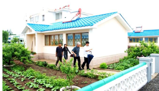
Jong Chol's hus med stor køkkenhave rundt om. Der er solcellepanel og vandopvarmningsanlæg på taget.
