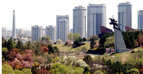
Mange nye beboelseshuse er bygget i Pyongyang indenfor det sidste år.
